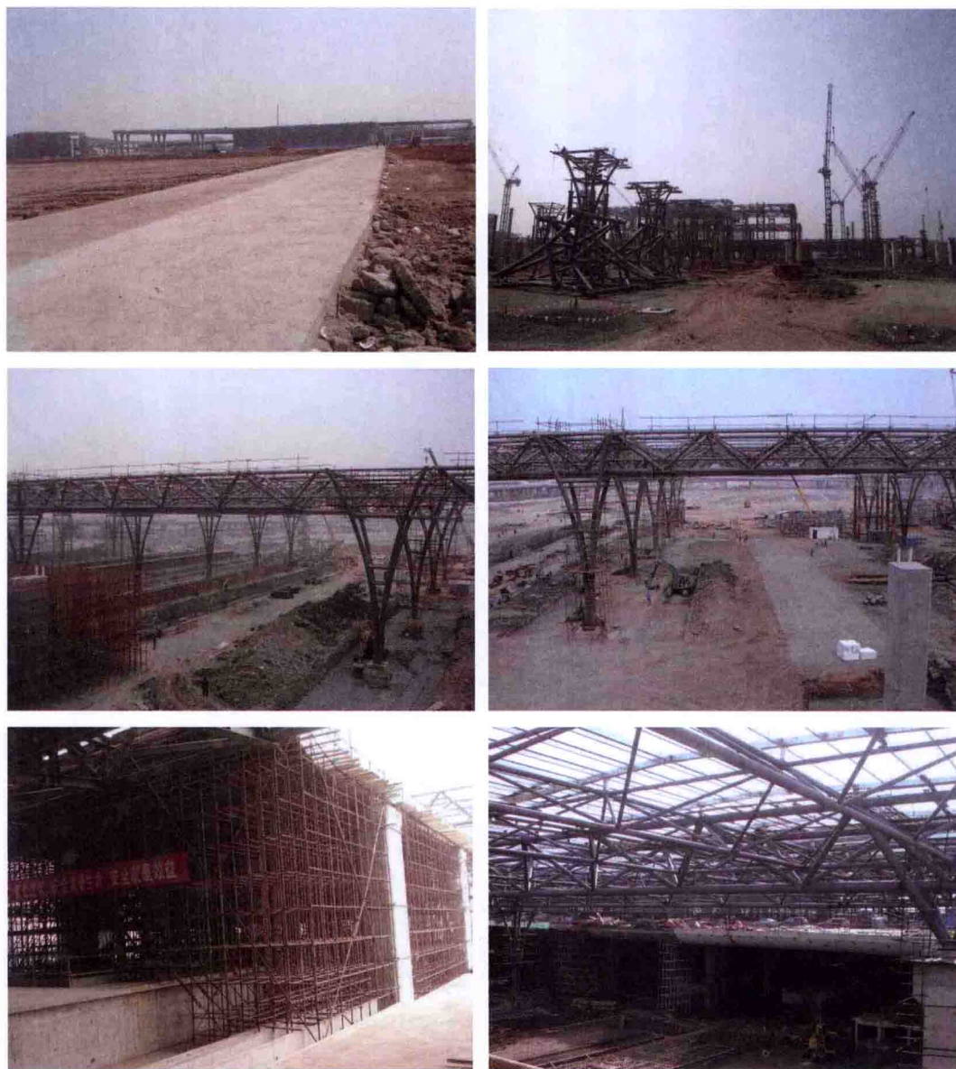
图 3-14 无柱雨棚、楼前高架、铁路站场同时施工
