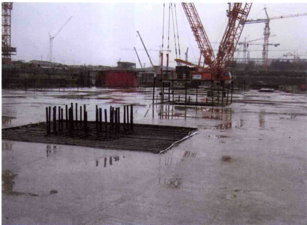
图 6-6 底板作为钢结构道路
