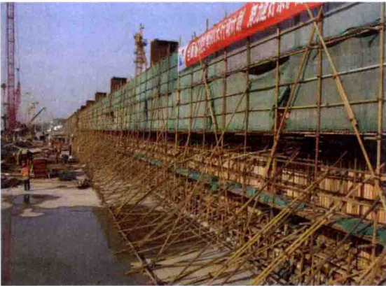
图 5-15 墙板模板支撑
