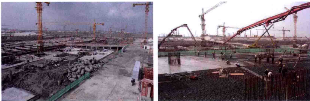
图 3-11 地下一层地板施工
