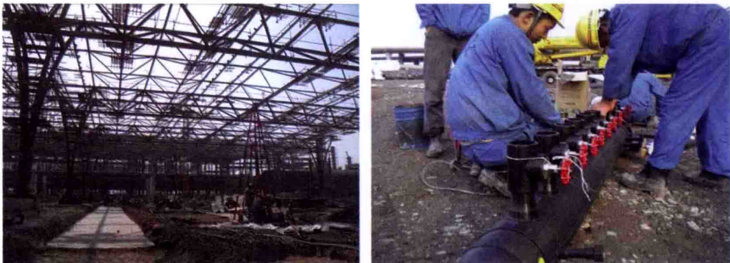
图 5-37 地源热泵钻孔施工及集水器作业
