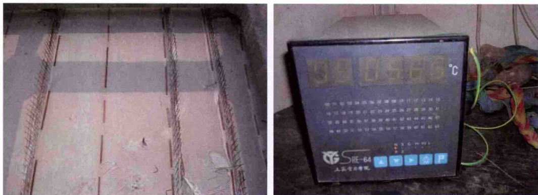
图 6-5 底板养护及电子测温
