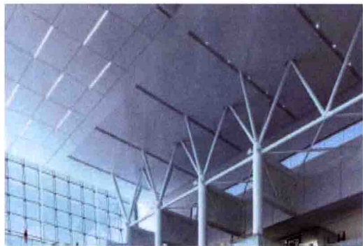
图 2-9 高架进站层顶部与立柱(局部)
