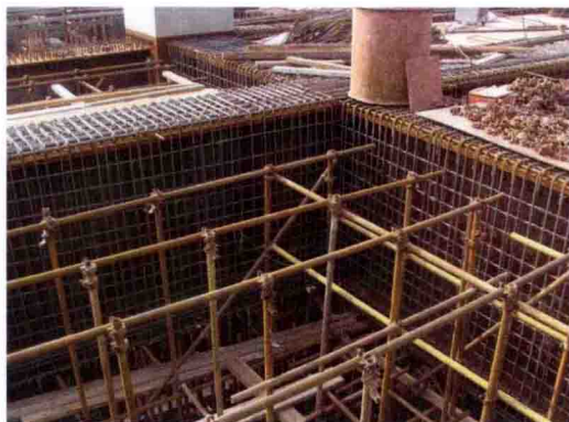
图 5-22 劲性梁柱节点
