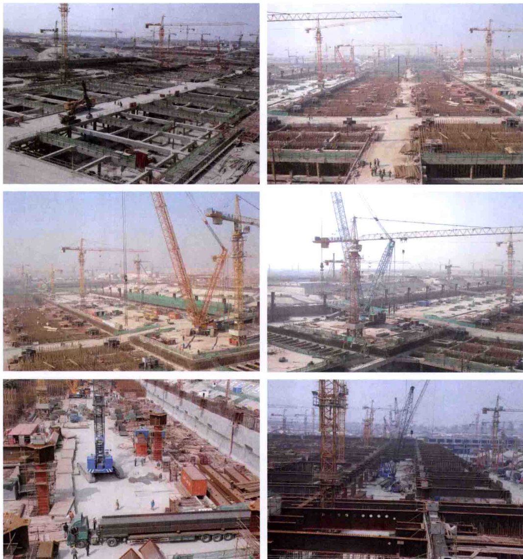
图 3-12 地下一层钢结构吊装
