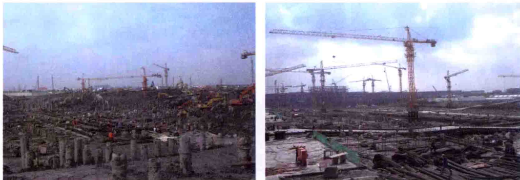
图 3-7 地下一层基坑开挖
