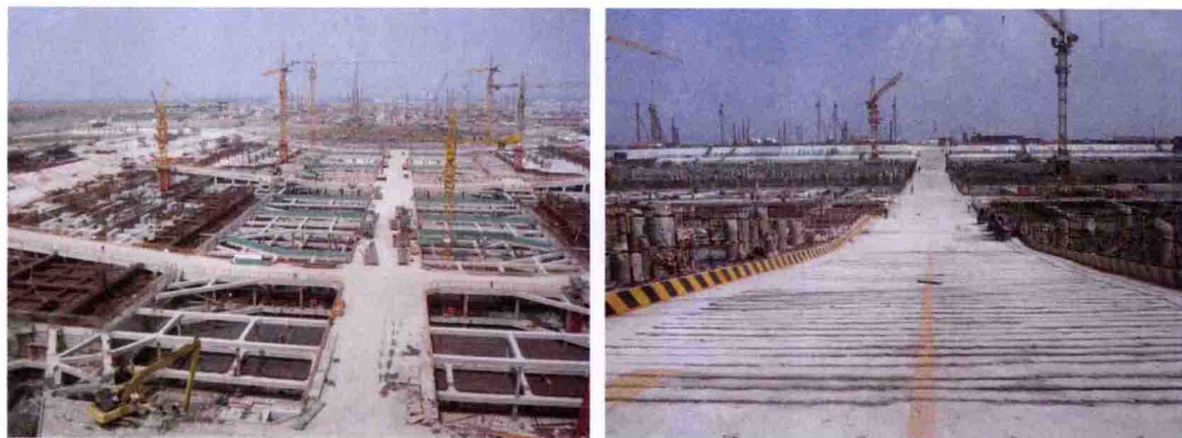
图 6-3 基坑施工阶段施工道路
