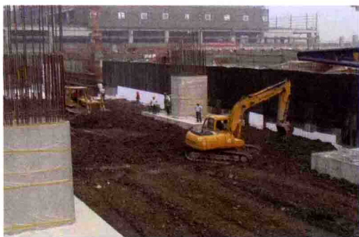
图 5-33 回填土施工
