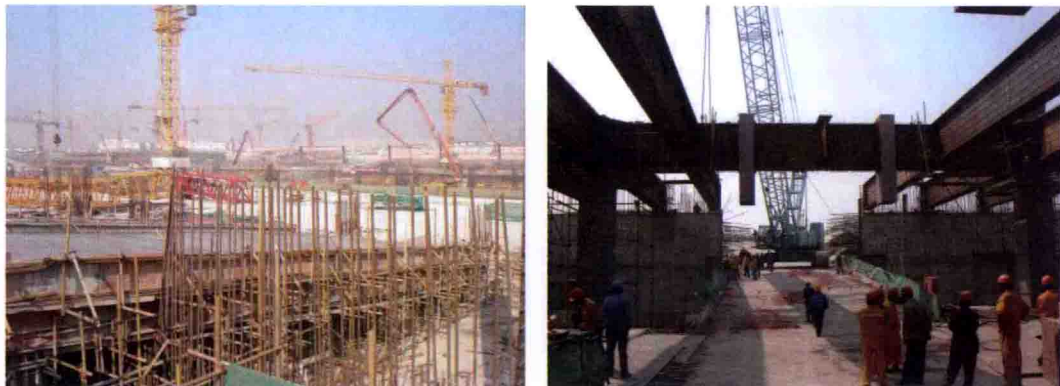
图 3-25 栈桥与底板衔接
