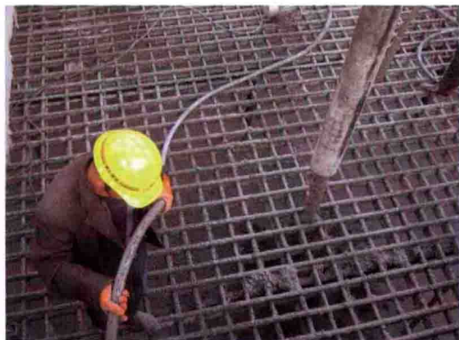
图 5-9 底板混凝土浇捣
