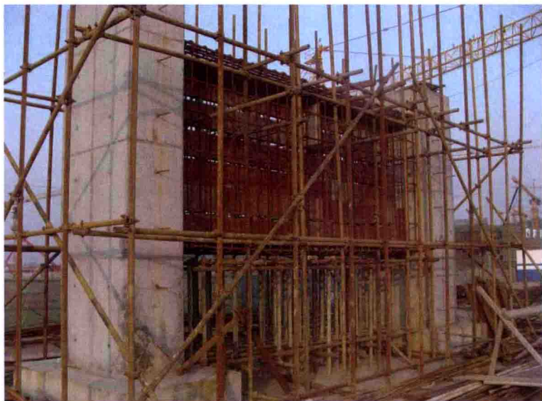
图 5-17 劲性梁钢筋绑扎试验
