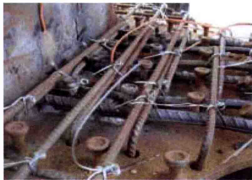
图 4-2 试验时梁纵向钢筋与型钢翼缘焊接连接
