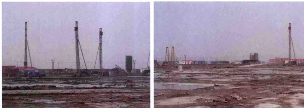
图 6-1 桩基、围护阶段施工道路
