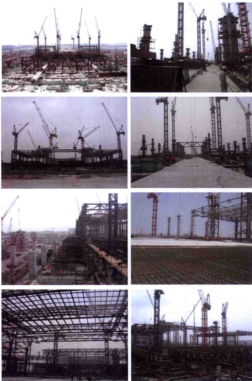
图 3-13 上部钢结构吊装
