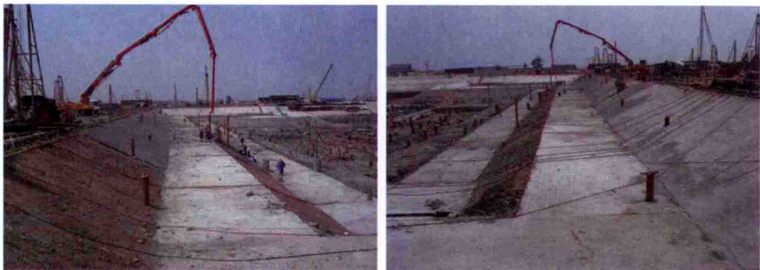
图 3-6 东侧与磁浮交界处临时边坡
