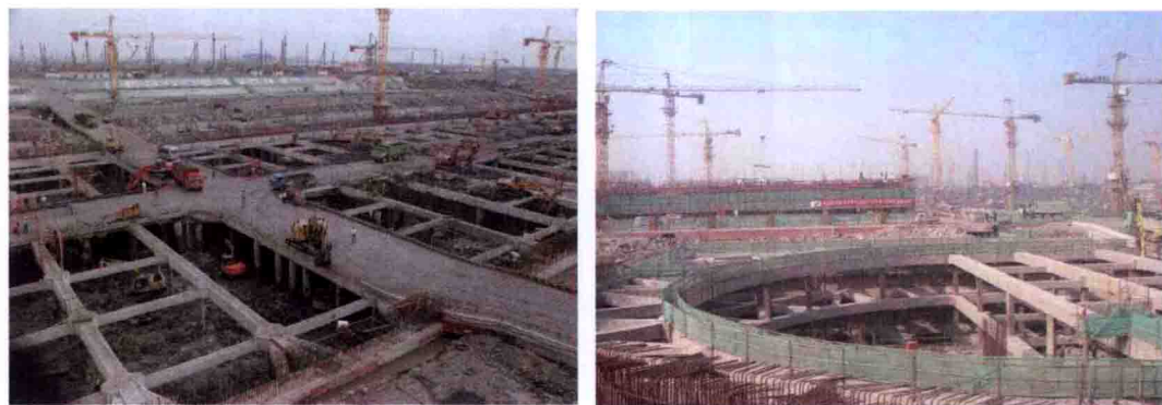
图 3-8 地下二层基坑开挖
