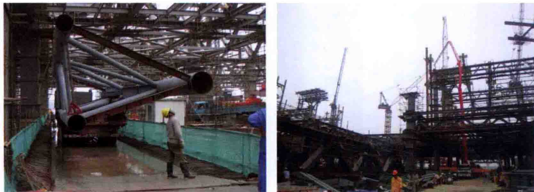
图 3-31 轨道层顶板上施工道路
