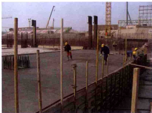
图 5-10 B1 层底板施工实景
