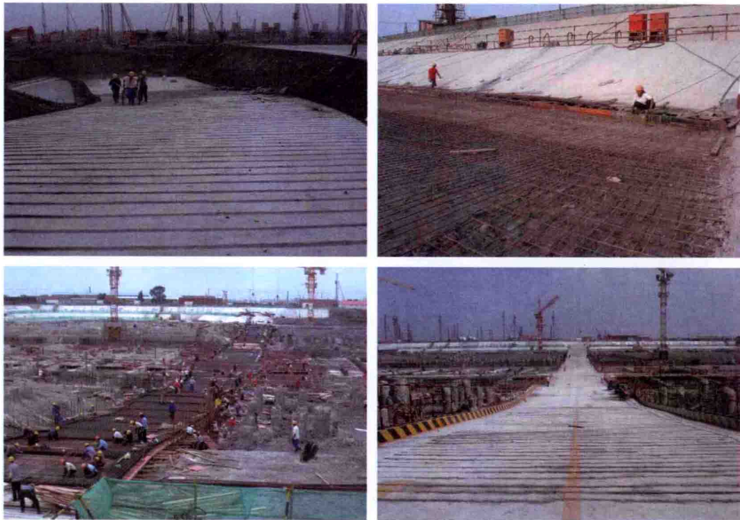
图 3-5 坑内临时道路布置
