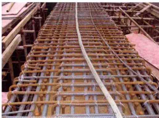
图 5-23 钢筋绑扎完毕后的劲性梁
