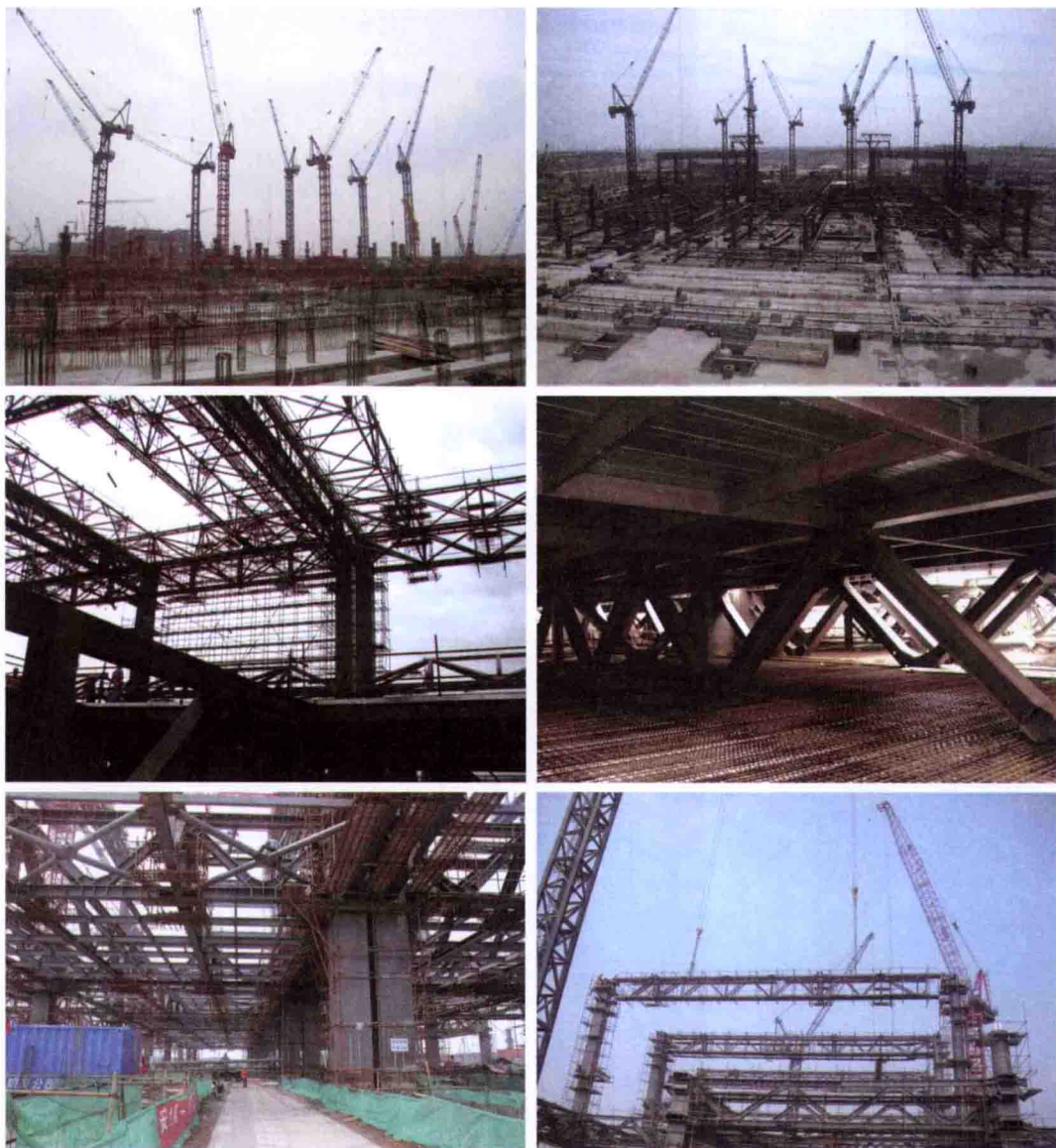
图 6-9 钢结构吊装
