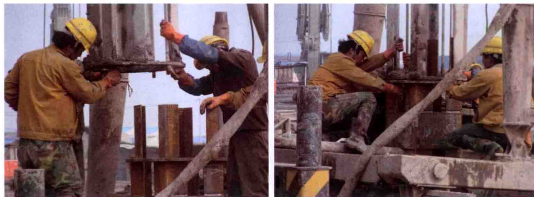
图 6-2 工具拆卸式格构柱安装
