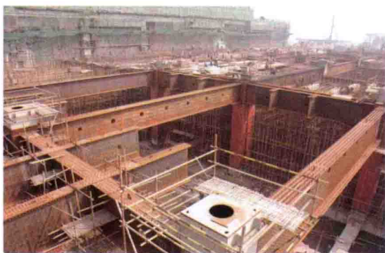
图 6-8 钢管柱与劲性梁连接
