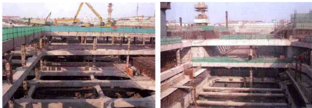
图 3-9 地下三层基坑开挖
