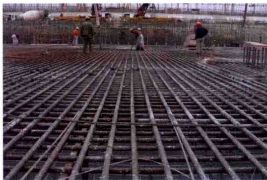
图 4-4 底板混凝土浇捣
