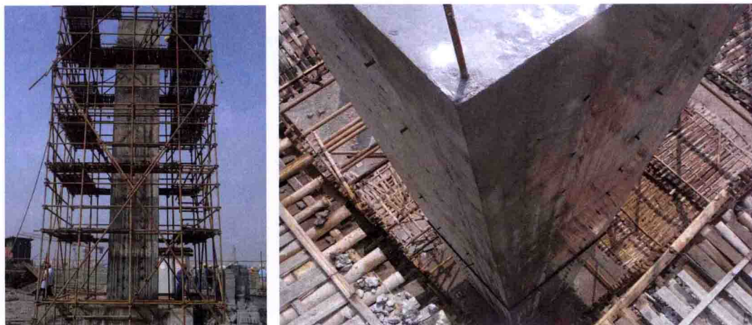
图 4-8 试验柱混凝土浇筑完成后效果
