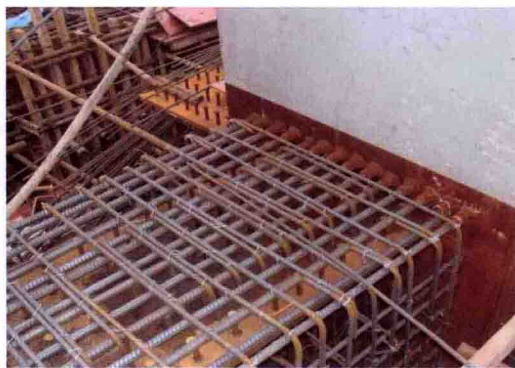
图 4-3 施工时梁纵向钢筋与钢管柱直螺纹连接
