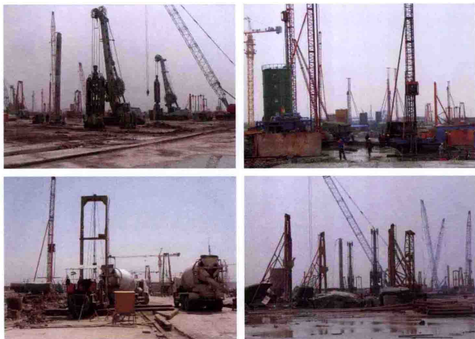
图 3-4 桩基围护阶段
