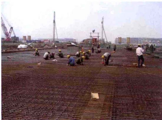
图 5-26 B1 层顶板施工
