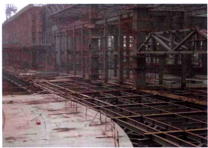
图 3-34 高架出入口与候车大厅衔接
