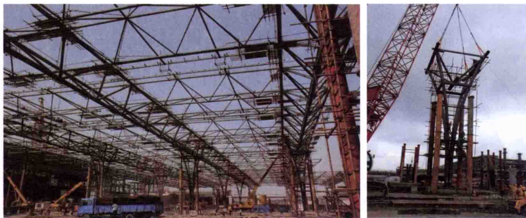
图 6-10 无站台柱雨篷钢结构吊装
