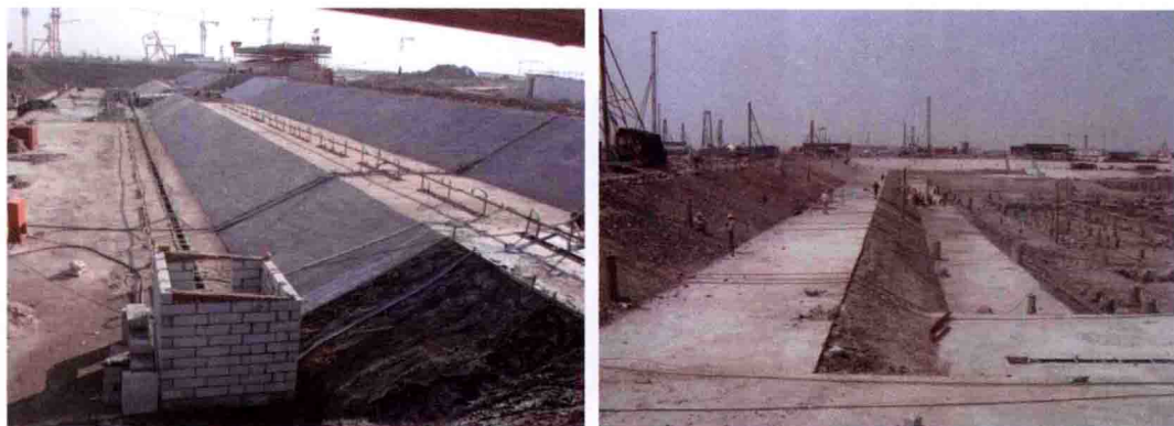
图 6-4 重力坝坝顶道路
