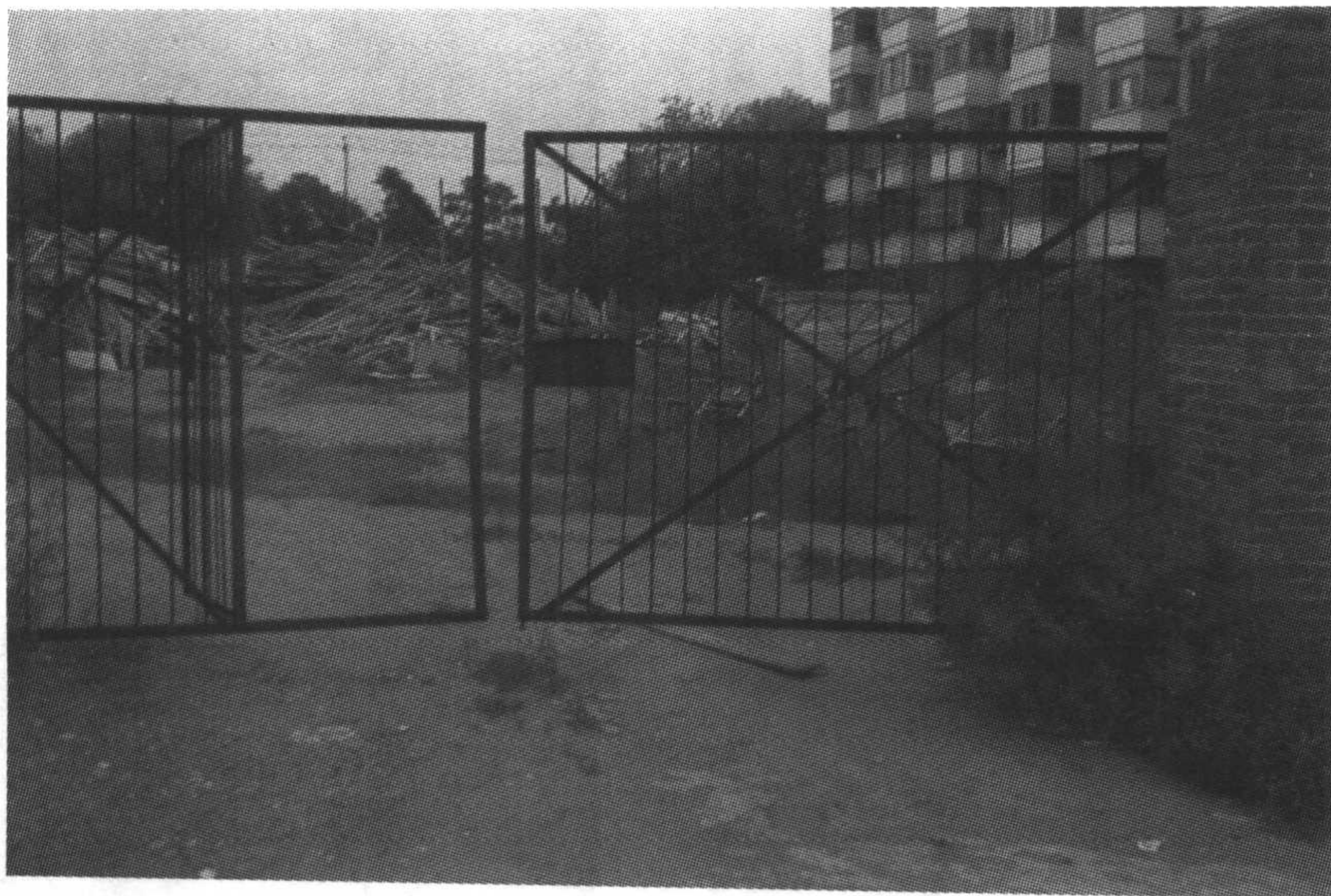
燕北园院内长期停工的建筑工地
